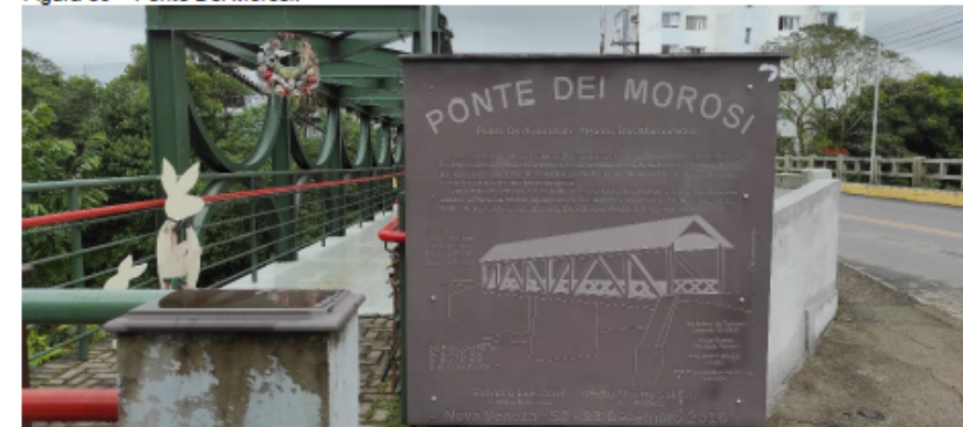
Figura 89 – Ponte Dei Morosi.
